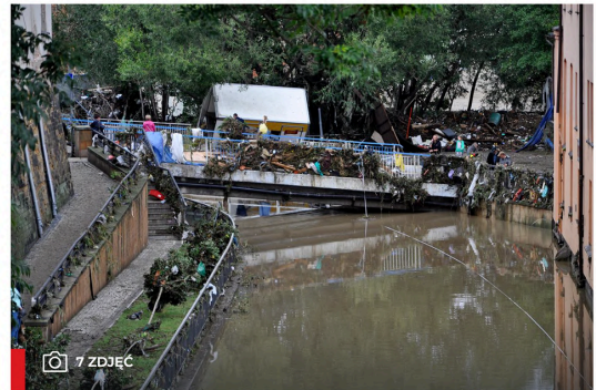
• Powódź w Kłodzku. Miasto zniszczone po zalaniu (Fot. Andrzej Dobkiewicz)
